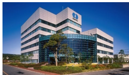
河村電器産業 本社(愛知県瀬戸市)
